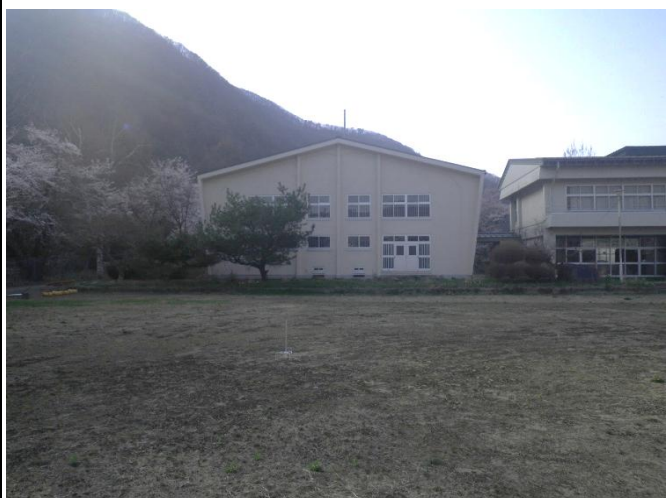
屋内運動場全景
