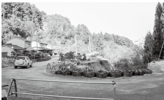
10月31日朝に開通した仮設道路（10/31撮影）
