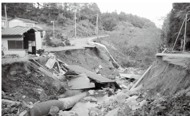
台風19号により被災した重茂・仲組地区の市道（10/16撮影）
