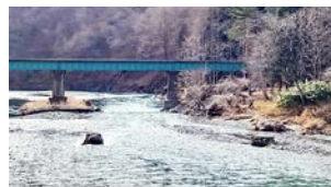
第31 閉伊川橋梁に残る旧橋脚跡
